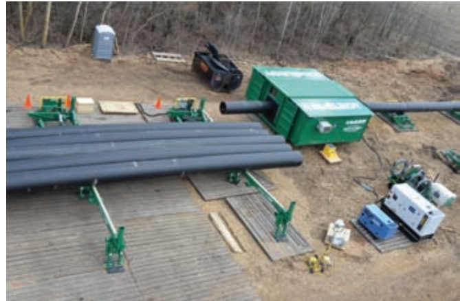
Фото 3. Сварочные работы с применением штабелера модели Megamc PolyHorse (для труб диаметром 500–1200 мм)
