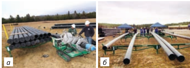
Фото 2. Сварочные работы с применением штабелеров модели PolyHorse (для труб диаметром 90–500 мм) и одной (а) или двух (б) сварочных машин
