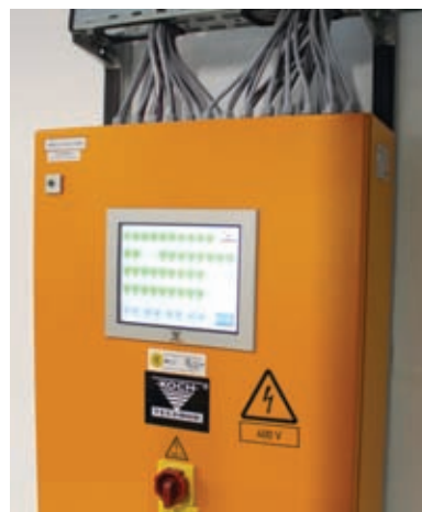
Фото 1. Каждая из пяти отдельных подсистем подачи и распределения полимерного материала имеет собственную систему управления и пульт S7 с сенсорным экраном, которые интегрированы в систему визуализации Koch-Technik (все фото: Koch-Technik)
