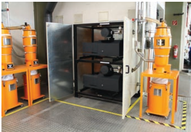
Фото 6. Сдвоенная компоновка вакуумных насосов и шумозащитный кожух позволили сэкономить место в цехе и понизить уровень шума от работы насосов до 8–10 дБ
